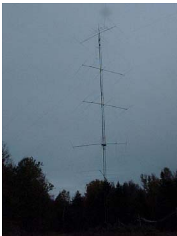
Dimmig 5 * 4 elements stack för 20 m hos K1TTT.
